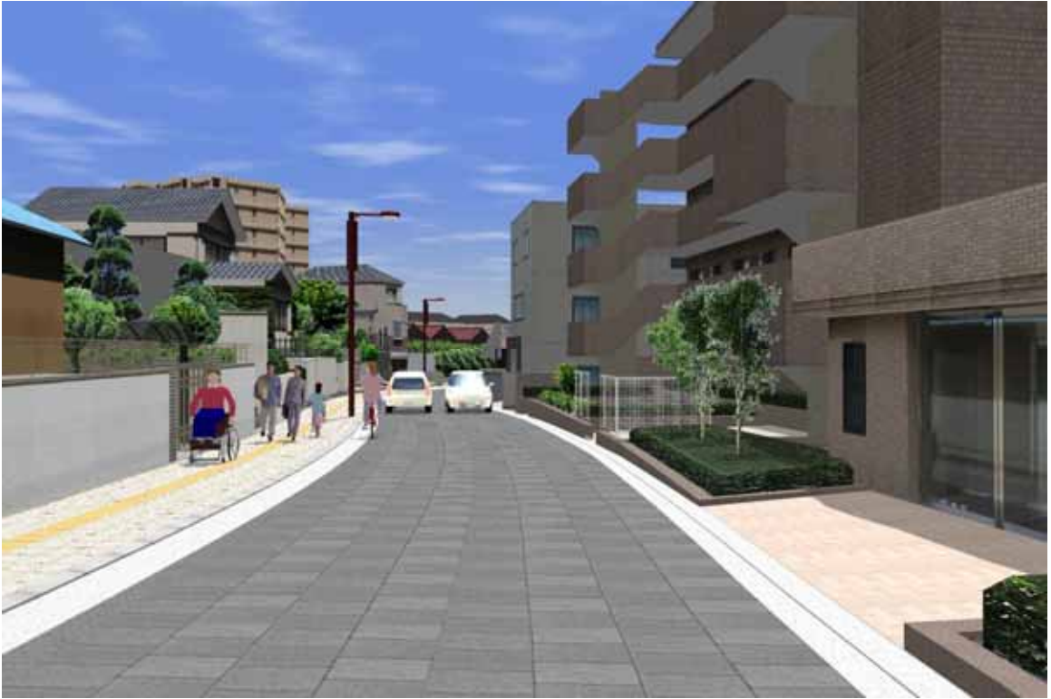
北区間 車道：半たわみ化粧仕上げ舗装、歩道：インターロッキングブロック舗装、 電線類地中化のための柱状型機器（街灯と一体化）
