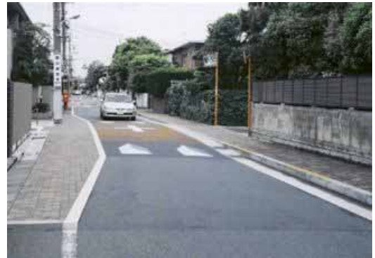
幅員の狭さくと長尺ハンプの組み合わせ 歩道と同じ高さまで車道を盛り上げ、反対側を張り出して狭さくをつくりだしている事例 東京都 品川区
