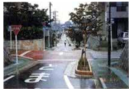
幅員の狭さくと長尺ハンプの組み合わせ 歩道と同じ高さまで車道を盛り上げ、反対側を張り出して狭さくをつくりだしている事例 東京都 品川区
