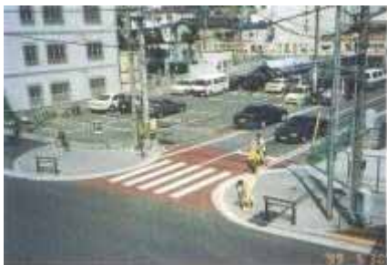
交差点での狭さく 相互通行の場合：歩道の張り出しによって車の流入減少と速度低減を図った事例 (大阪市)
