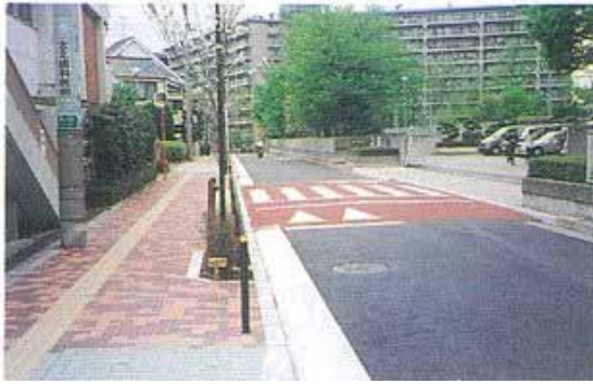
道路のセンターライン削除（車道幅員 5.5m）とハンプ設置
