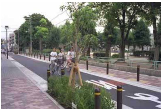
一方通行車道内植栽による狭さく 左右交互に植栽を設けて車を蛇行運転させている事例 大阪市(大阪市ホームページより)
