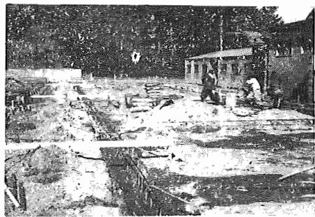
布佐中学校改築工事 旧校舎の取りこわしも終了、改築工事に入り、1月28日には基礎コンクリートの配筋検査がおこなわれました。 [写真右前方パネル校舎]
