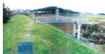
▲工事前の堤防と樋管
