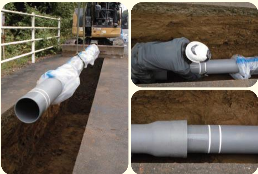
▲耐震性に優れた管(ダクタイトル鉄製 口径200mm)に取り替えている様子
