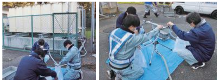
◀学校の受水槽から応急用のじゃ口をつなげて、給水袋へ水を入れている様子(応急給水)
