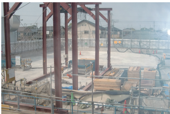
▲1号配水池屋上工事实施中 (平成26年4月)
