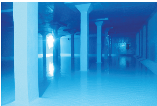
▲2号配水池内工事完成 (平成26年2月)
