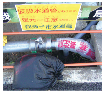
▲ 仮設配管接続状況
