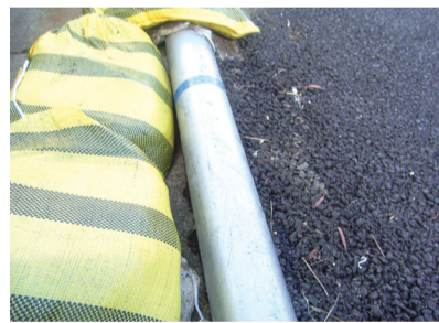
▲φ100mm仮設ステンレス管
