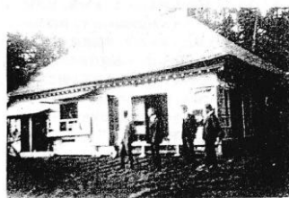
写真 5-1 移築後の我孫子母屋南面 (撮影年月日不明 村川家蔵)
